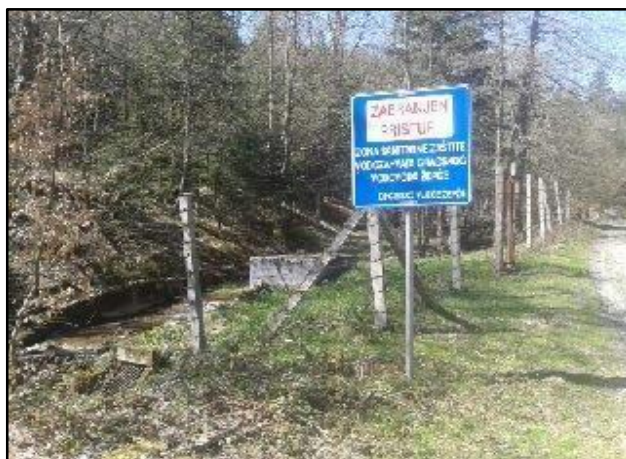
Slika 17. Objekat vodozahvata "Ravna rijeka"
