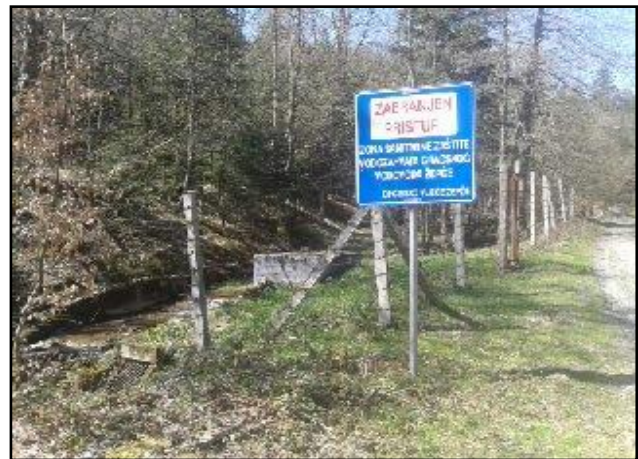
Slika 17. Objekat vodozahvata “Ravna rijeka“
