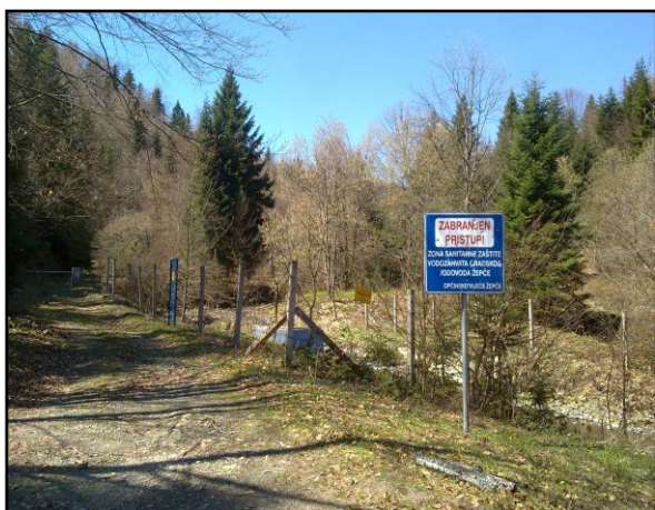
Slika 16. Objekat vodozahvata "Ograjina"
